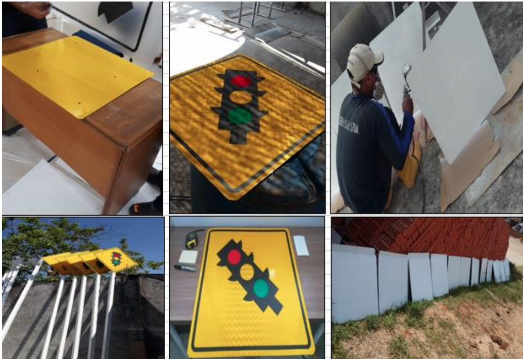
Señales verticales nuevas instaladas
